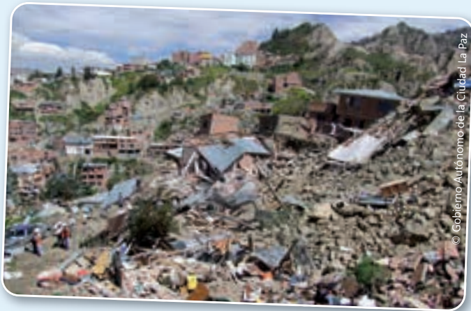
Zerstörte Häuser nach einem Erdbeben.
