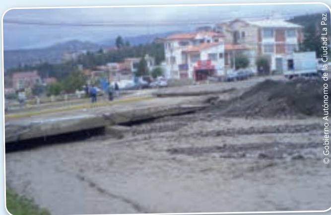
Schäden nach Hochwasser und Überschwemmungen sind nicht selten.
