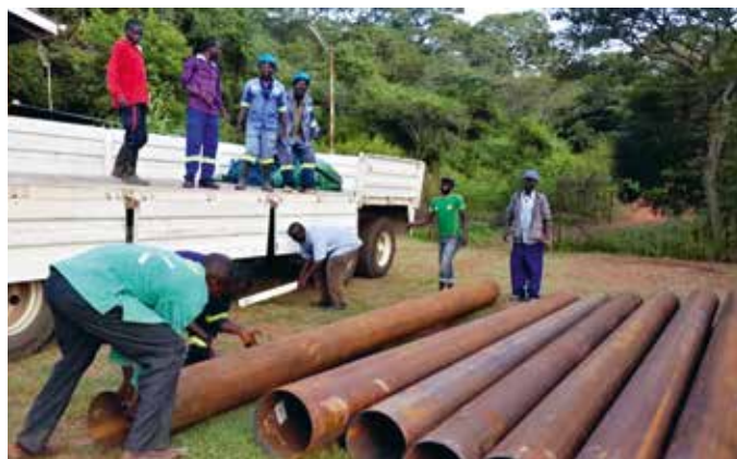
In einer Gemeinde in Simbabwe werden neue Rohre für Wasserleitungen geliefert.
