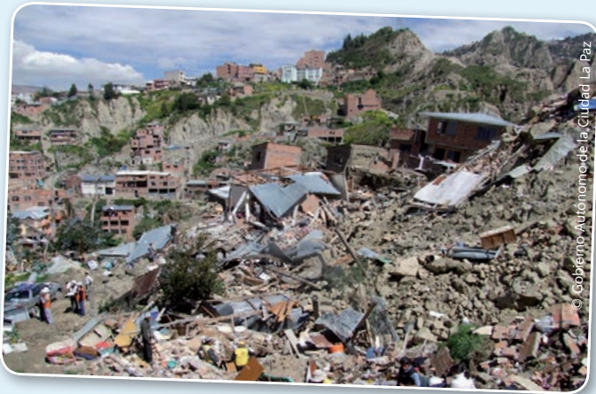
Zerstörte Häuser nach einem Erdbeben.
